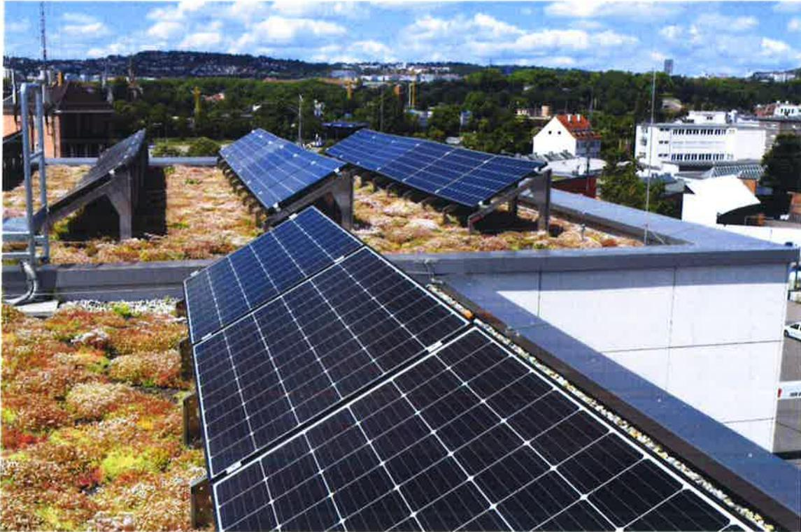
Abbildung 1: Solargründach mit extensiver Dachbegrünung. Quelle: Bundesverband GebäudeGrün e.V. (19.02.2021): <https://www.gebaeudegruen.info/aktuelles/news/details/zwei-neue-arbeitshilfen-solar-gruendach-fachinformation-und-fokus>
