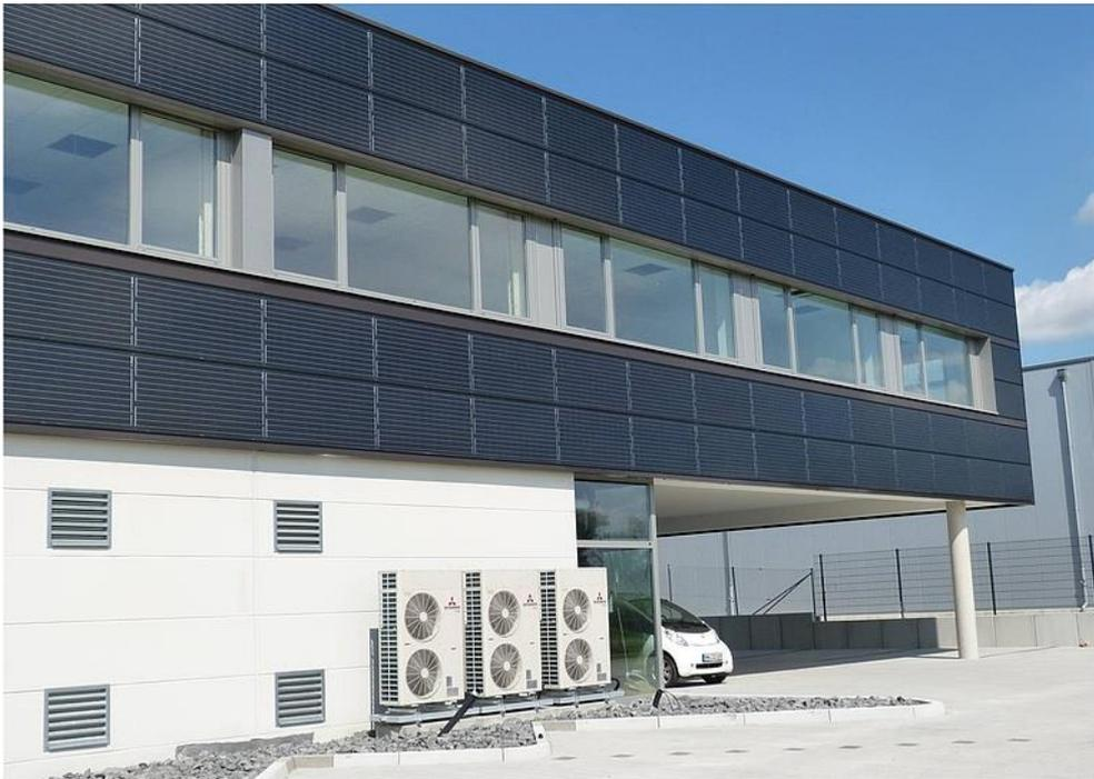
Abbildung 1: Photovoltaik in der Fassade, Quelle: energie-experten.org, <https://www.energie-experten.org/erneuerbare-energien/solarenergie/solaranlage/photovoltaik-fassade>
